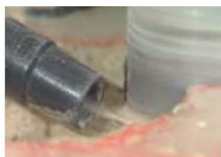
Absaugen des Bohrschlamm
