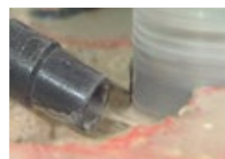
Absaugen des Bohrschlammes
