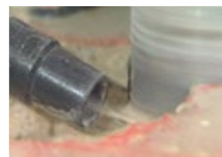
Absaugen des Bohrschlamm
